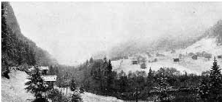
Fig. 3 - Il conoide -frana del Rebrut, che costituiva lo sbarramento del Lago Nuovo. Nel suo profilo a linea distesa è evidente (a sinistra) lo squarcio prodotto dal Vanoi nel 1882. (Foto G. Tomasi)
