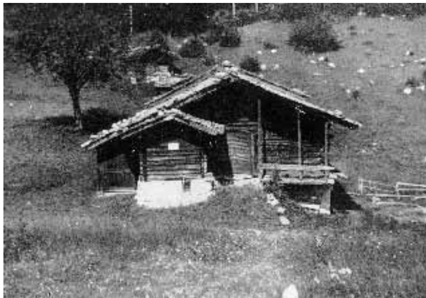
Fig. 1 - Fienili in località S. Giovanni di Primiero. Copertura e scatola sono costituite da tronchi appena sbazzati di larice, sulle cui testate è possibile seguire l'andamento degli accrescimenti annuali diametrali. (Foto: Migliorini)
