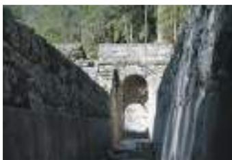
Oltre la scanalatura, ricavata a mertellina nello stesso blocco dei piedritti, la superficie di scorrimento della paratia è rivestita con malta cementizia in buono stato di conservazione. Alla base, un profilo ad L di cm 15x5, alta cm 80, riveste l'angolo destro (ovest). Probabilmente si tratta di un rivestimento reso necessario dall'erosione della pietra prodotta dal flusso d'acqua in ingresso. Tutta la parte basamentale della chiusa si presenta molto levigata.
