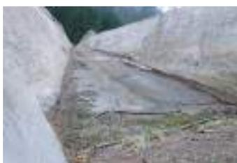
completamente “rivestita” da muschi ed altri vegetali. Lo sfioratore, in corrispondenza del quale il muretto, più basso di cm. 12, presenta una serie di ferri che fungevano da blocchi e da sostegni per un sistema di tavole di chiusura, aveva però anche un’importante funzione: regolare il passaggio dell’acqua nei termini indicati dagli accordi, ributtando subito nel torrente, tramite il canale di scarico, eventuale acqua in eccesso.
