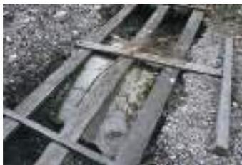
dere la morfologia e la struttura del tratto stesso. Al di sotto di una soletta il cls a pezzatura medio grande è venuto alla luce un tratto di condotto circolare di sezione trapezia analogo al tratto scoperto, su cui si imposta una volta di tipo a botte.
