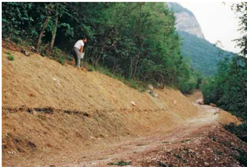
**Foto 2.6.4.3.1.** Semina con mulch. In pendenza, la distribuzione del seme va effettuata dopo la pacciamatura: in questo modo il seme, fermato al suolo dal materiale pacciamante, non scivola fino alla base della scarpata (foto Carbonari).
