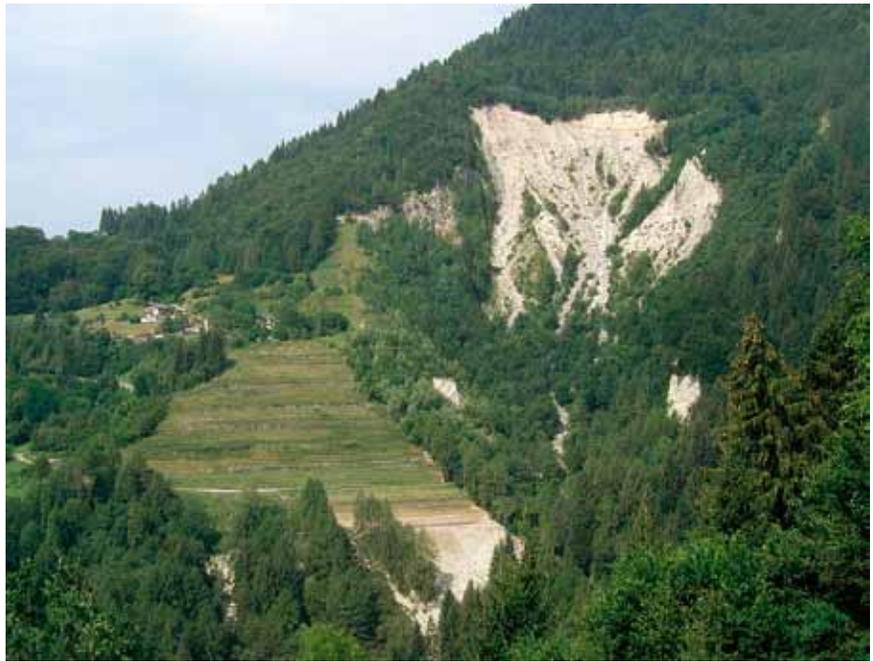
**Foto 2.3.1.** Frana Gravon (Pieve Tesino, TN), prima (sopra) e dopo (sotto) gli interventi di ripristino. Nella foto in basso si osserva che l'uniformità morfologica conseguente al modellamento è molto più evidente con vegetazione finale di tipo erbaceo (parte sinistra della foto, sotto le abitazioni) che di tipo arboreo (parte destra della foto) (Foto Carbonari).
