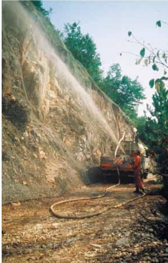
**Foto 2.6.4.4.1.** Idrosemina. Una scarpata rocciosa molto pendente viene inerbata con una soluzione contenente seme di ecotipi nativi (foto Carbonari).
