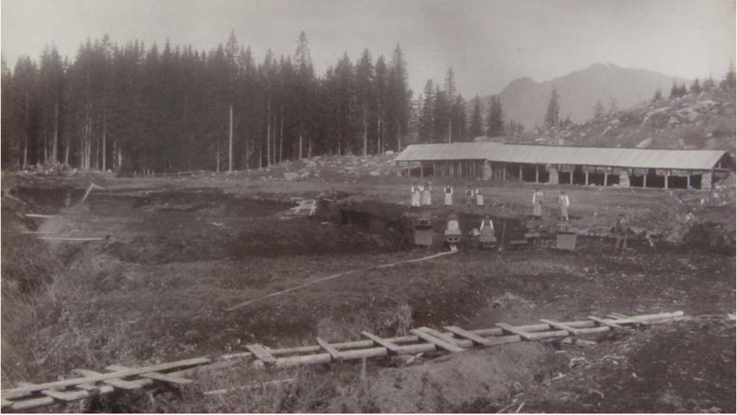
L'immagine chiarificatrice. I lavori di scavo nella torbiera. Anno 1889 circa.
