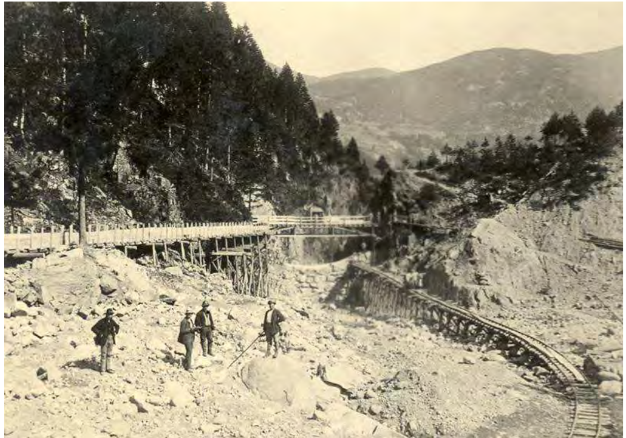
Torrente Brusago – costruzione serra (1910)
